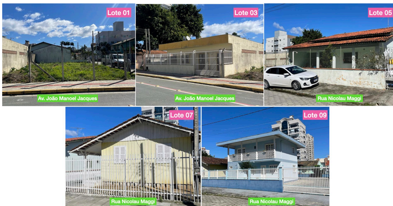
Figura 3 - Fotografias dos imóveis pretendidos. Referência das imagens Julho de 2023.
