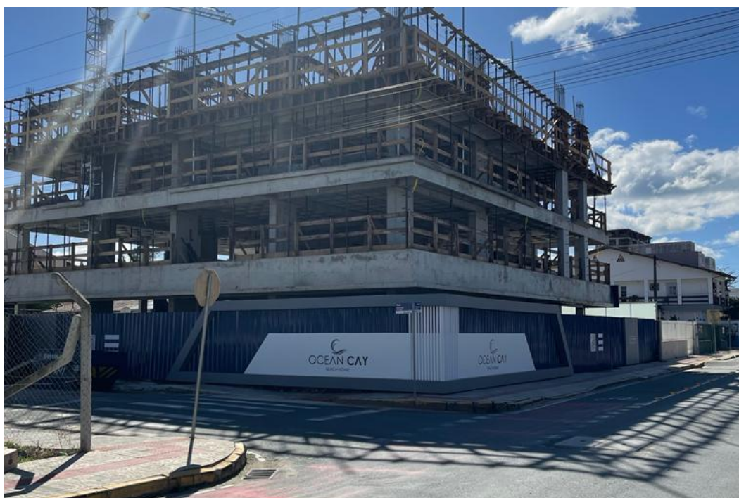
Figura 5 - Empreendimento em construção em frente ao empreendimento pretendido.
