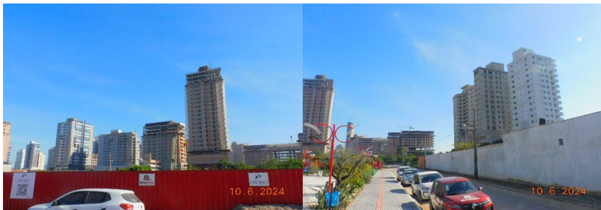
Figura 42-Obras no entorno do empreendimento. Fonte: Google Maps, 2024.
