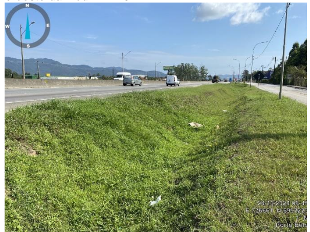
d) Sarjeta de drenagem entre a Rod. BR-101 e marginal leste da rodovia (Posto Angeloni)
