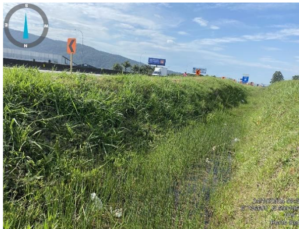
a) Sarjeta de drenagem entre a Rua Santos Dumont e oeste da Rod. BR-101
