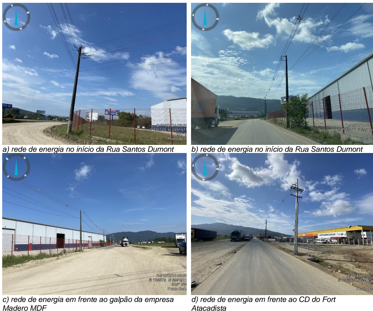
Figura 10: Registros fotográficos da rede de energia elétrica no entorno do empreendimento | Fonte: Empreendedor (2024)
