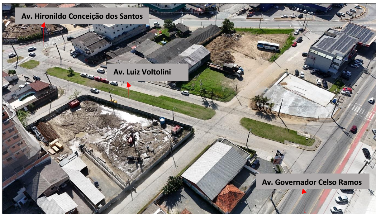
Figura 36 – Condições de tráfego e das vias na área vizinhança imediata.
