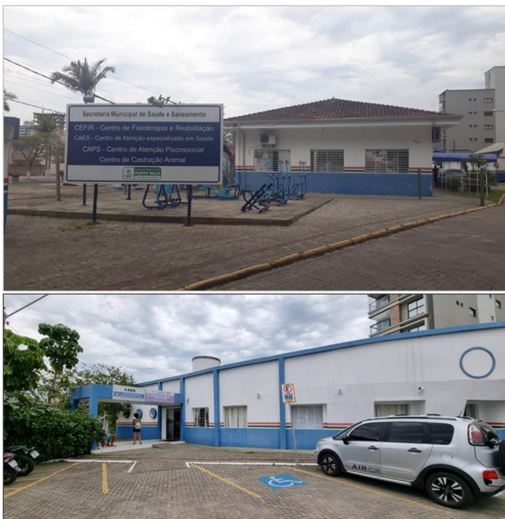
Figura 26 - Centro integrado de atendimento no município de Porto Belo.
