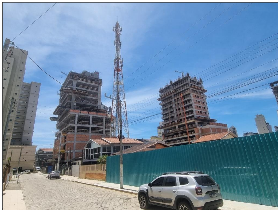
Figura 25 -Torre de amplificação e replicação de sinal das operadoras de telecomunicação.
