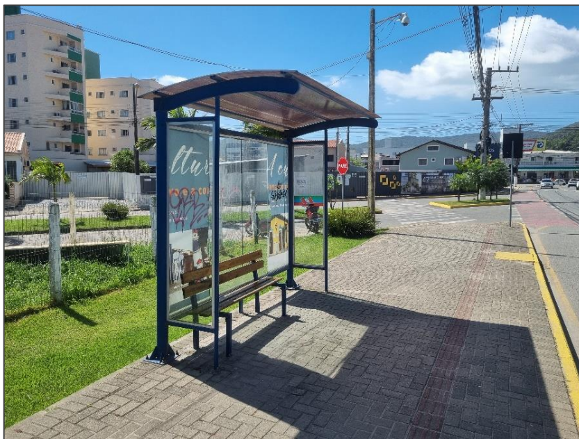
Figura 40 – Ponto de ônibus na Área de Vizinhança Direta de do empreendimento.
