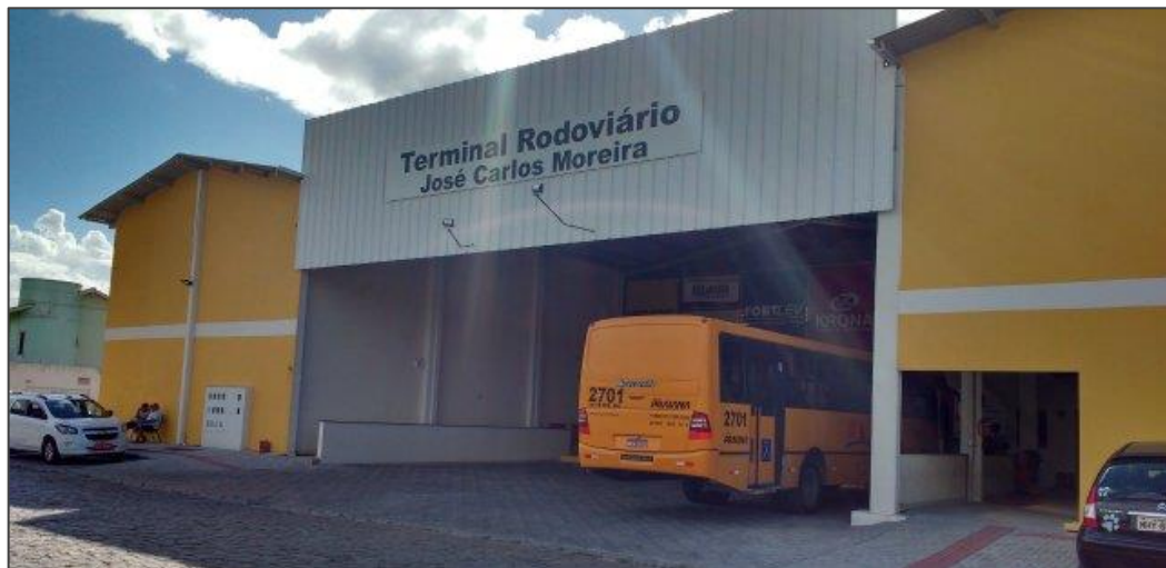
Figura 38 – Terminal Rodoviário José Carlos Moreira na cidade de Porto Belo.
