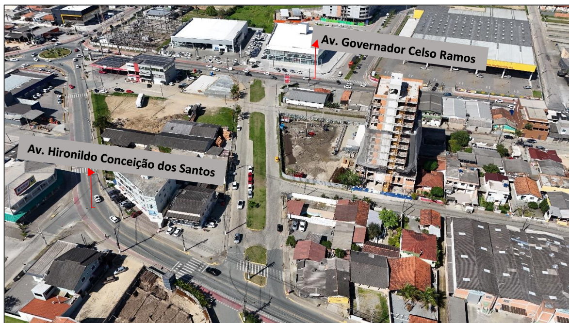
Figura 35 – Vista da estrutura viária da Área de Vizinhança Direta do empreendimento.
