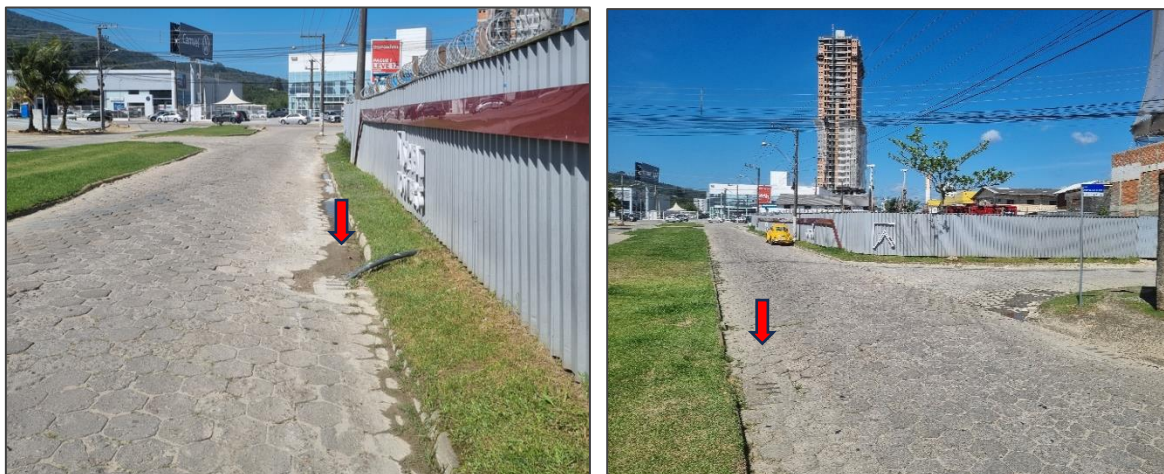
Figura 24 – Estrutura de drenagem municipal na área de vizinhança imediata do empreendimento.
