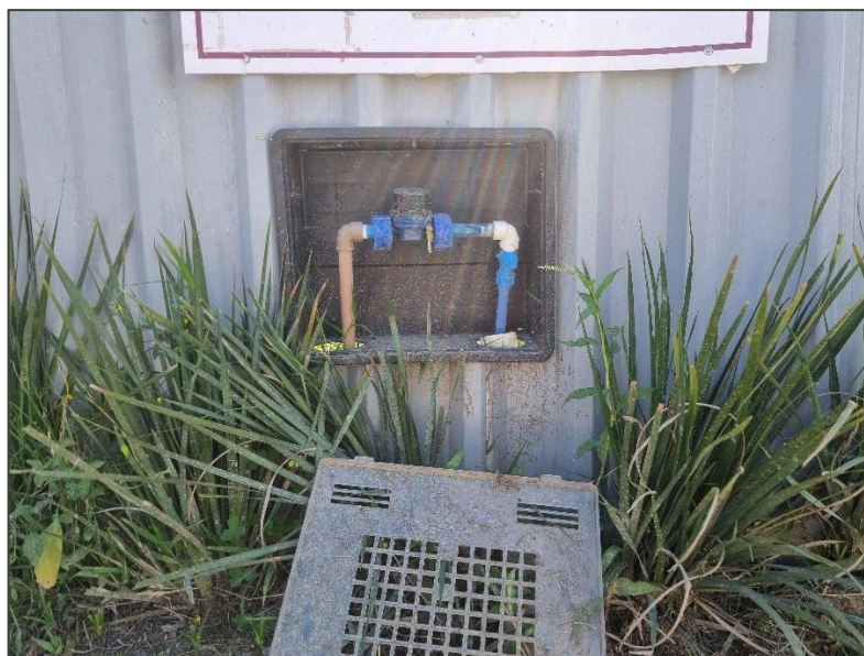
Figura 23 – Cavalete de água para abastecimento do empreendimento durante a instalação.
