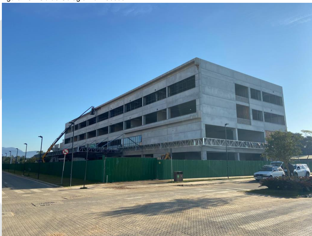
Figura 43 - Obras Colégio Bom Jesus.
