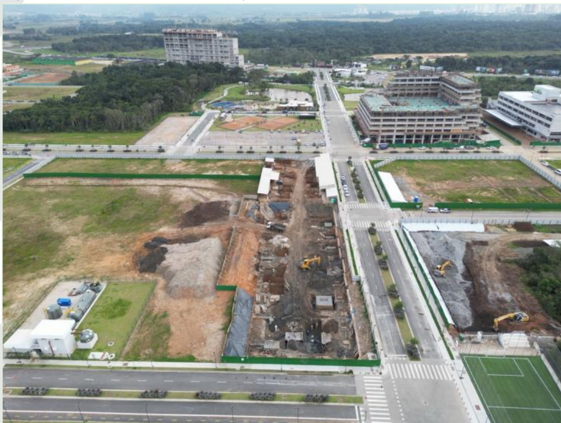
Figura 35 - Vista aérea da Área de Vizinhança Mediata.
