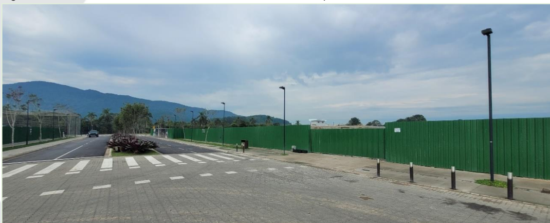
Figura 13 - Estrutura viária em ótimo estado no entorno do empreendimento.
