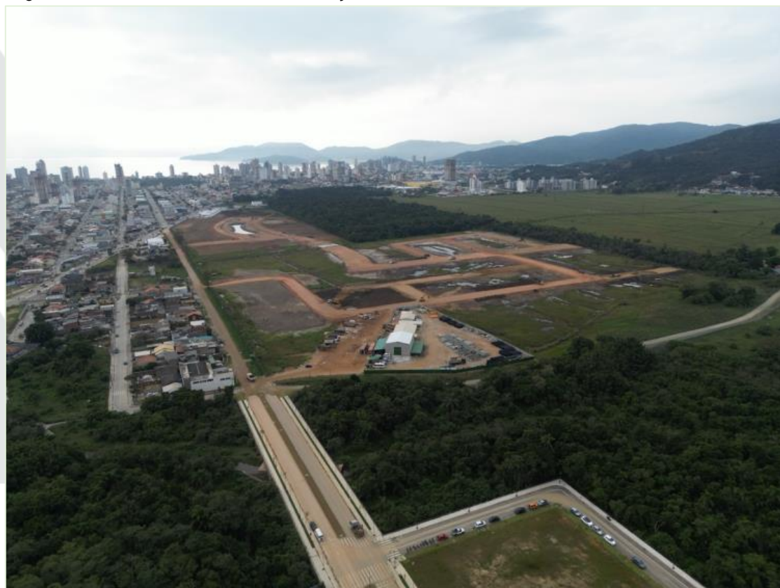
Figura 37 - Vista aérea da Área de Vizinhança Mediata.
