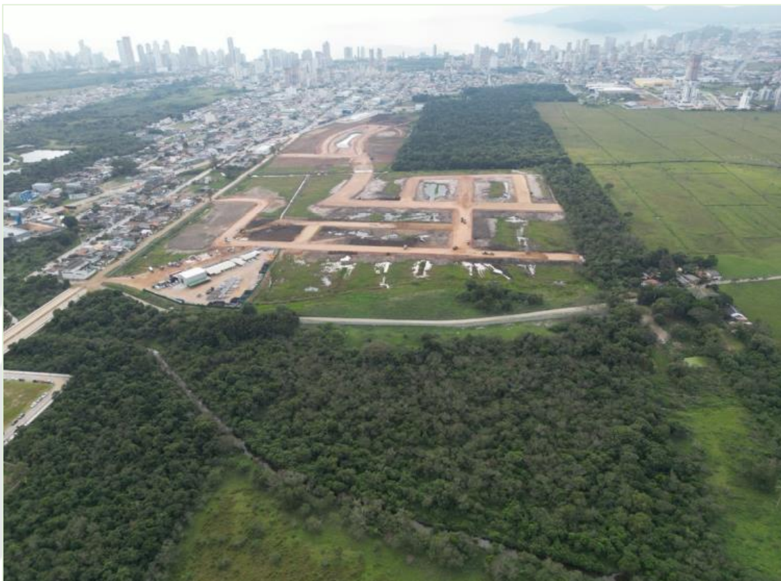
Figura 38 - Vista aérea da Área de Vizinhança Mediata.
