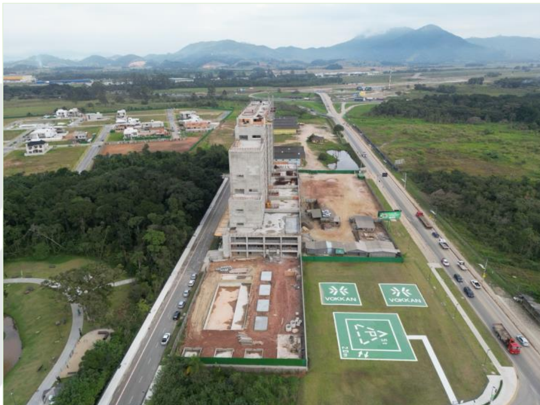
Figura 36 - Vista aérea da Área de Vizinhança Mediata.
