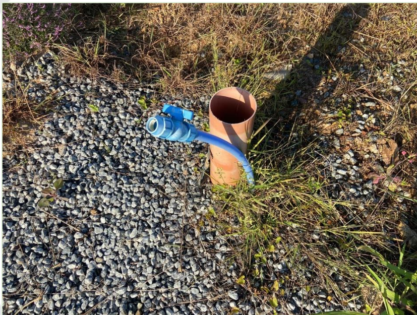
Figura 66 - Ponto de ligação de água.
