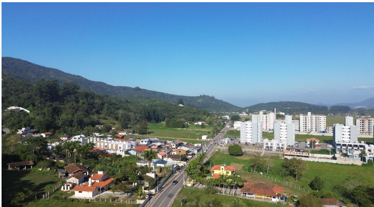
Figura 28- Imagem aérea da caracterização do uso do solo no entorno do empreendimento. Fonte: RIBAS Consultoria Ambiental, 2024.
