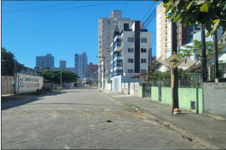
Figura 13: Registro Fotográfico da Rua Felipe Sestrem
