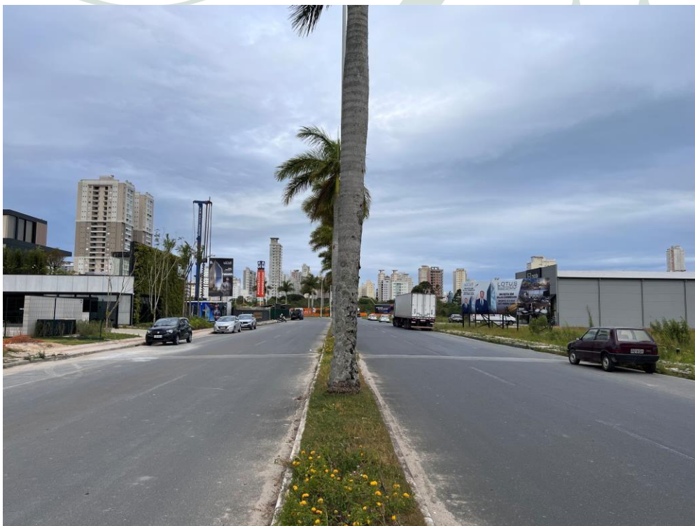
Figura 20. Visualização da situação da Av. Rio Perequê. Fonte: do autor, 2022.
