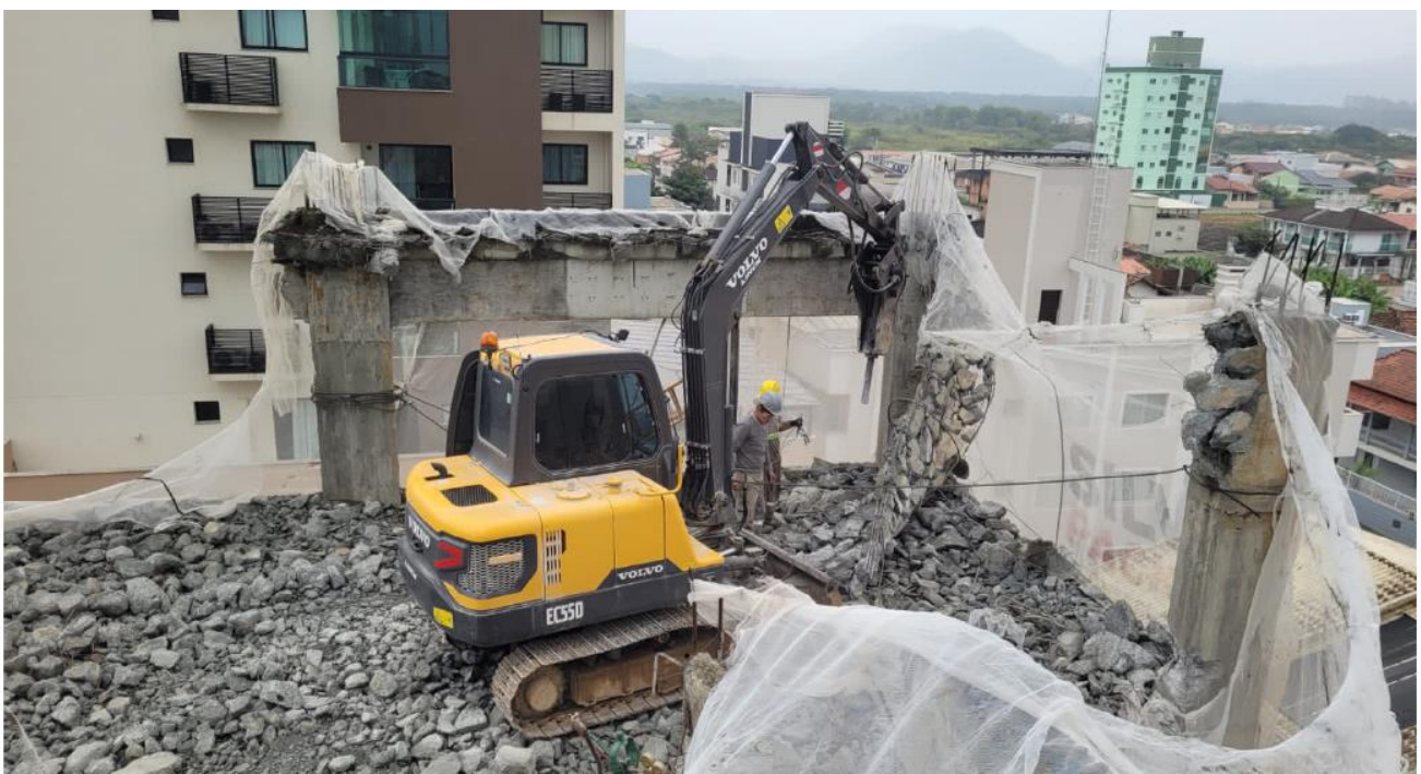
Figura 3 - Demolição em curso no local do empreendimento. Fonte: Cedida pelo arquiteto responsável, agosto 2023.
