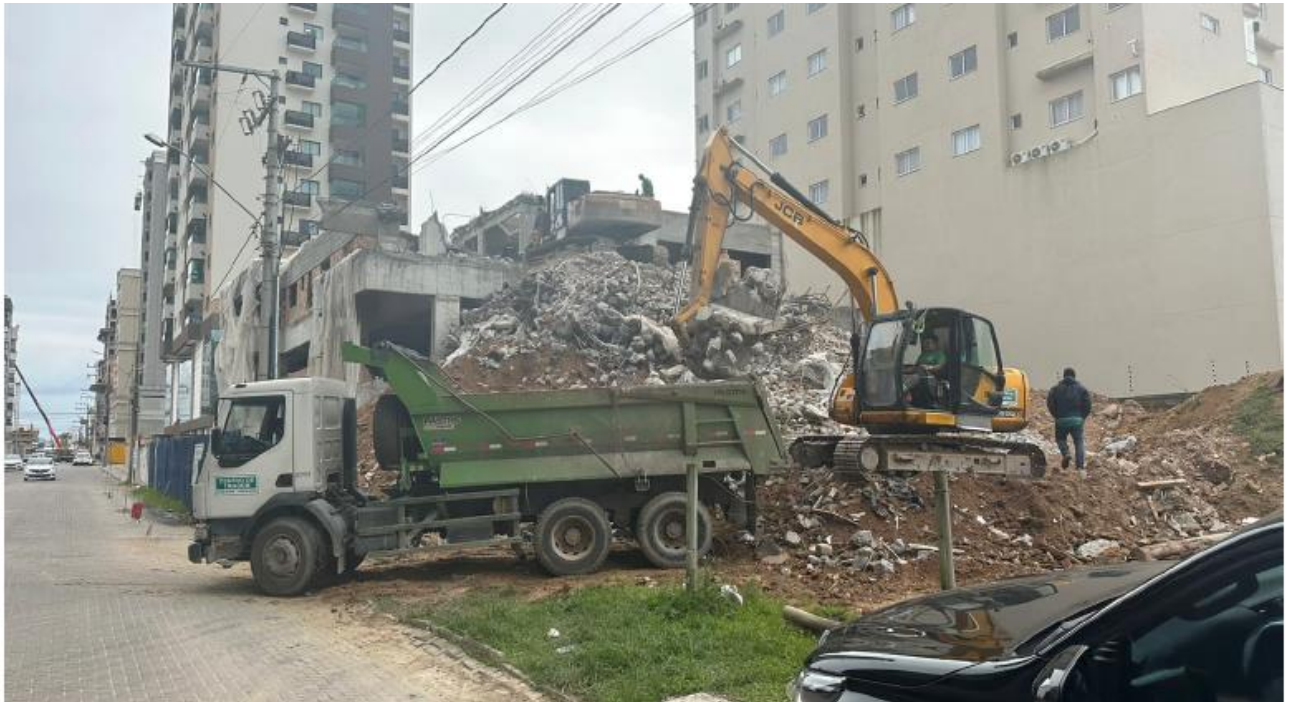
Figura 2 - Demolição em curso no local do empreendimento. Fonte: Cedida pelo arquiteto responsável, agosto 2023.
