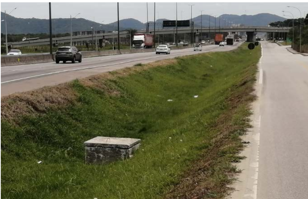
Vistas da Via Marginal e da vala de drenagem.
