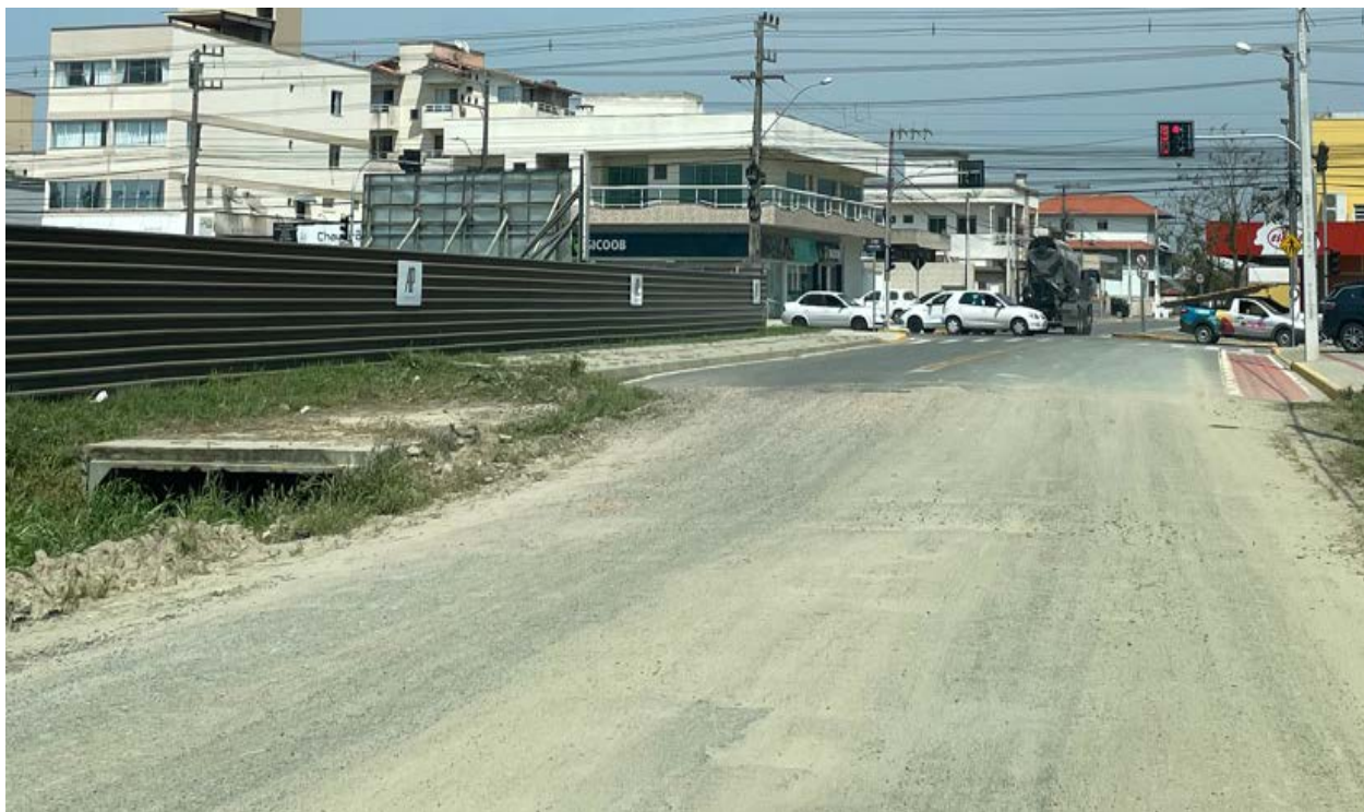
Término da pavimentação e da drenagem pluvial já executadas na Avenida Colombo Machado Salles.
