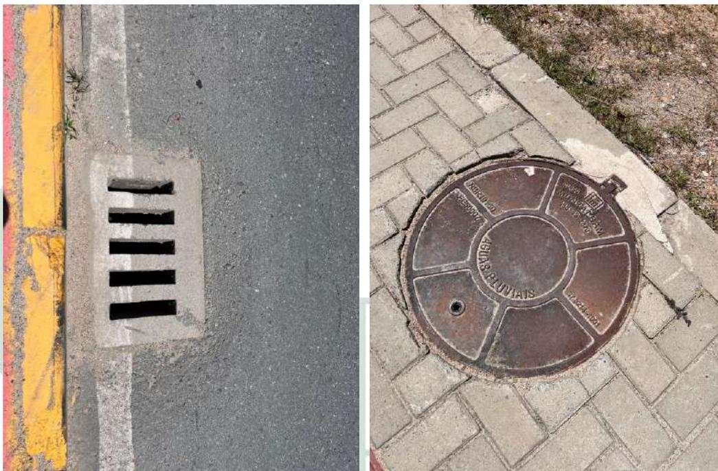
**Figura 20. Visualização dos dispositivos de drenagem pluvial instalados na área do entorno do empreendimento. Fonte: do autor, 2023.**
