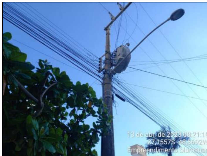
Figura 14. Poste de iluminação presente na rua do empreendimento.
