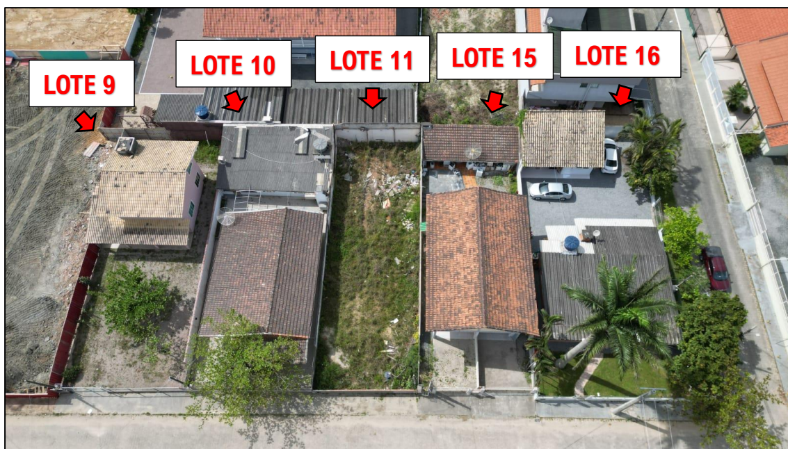
Figura 1. imagem de drone dos imóveis que compõem do empreendimento.
