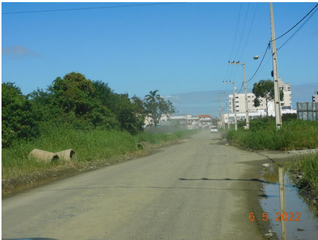
Figura 12- Avenida Colombo Machado Sales (atualmente Santino Ludovino Voltolini), evidenciando a suspensão de material particulado pelo tráfego de veículos pesados e a falta de dispositivos de drenagem pluvial. Fonte: RIBAS Consultoria Ambiental, 2022.
