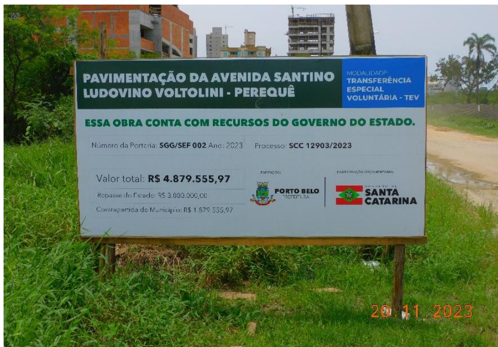
Figura 13- Placa da obra de pavimentação na Avenida Santino Ludovino Voltolini.
