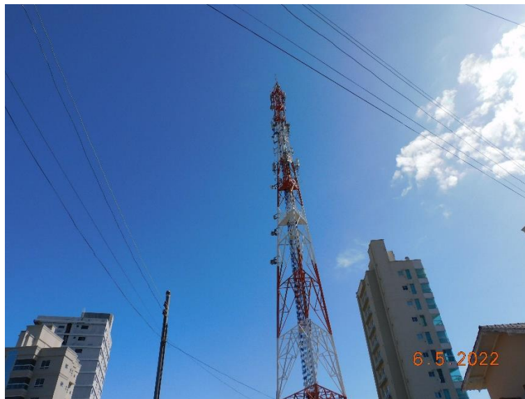
Figura 48- Dispositivo de telecomunicação na área de entorno do imóvel. Fonte: RIBAS Consultoria Ambiental, 2022.
