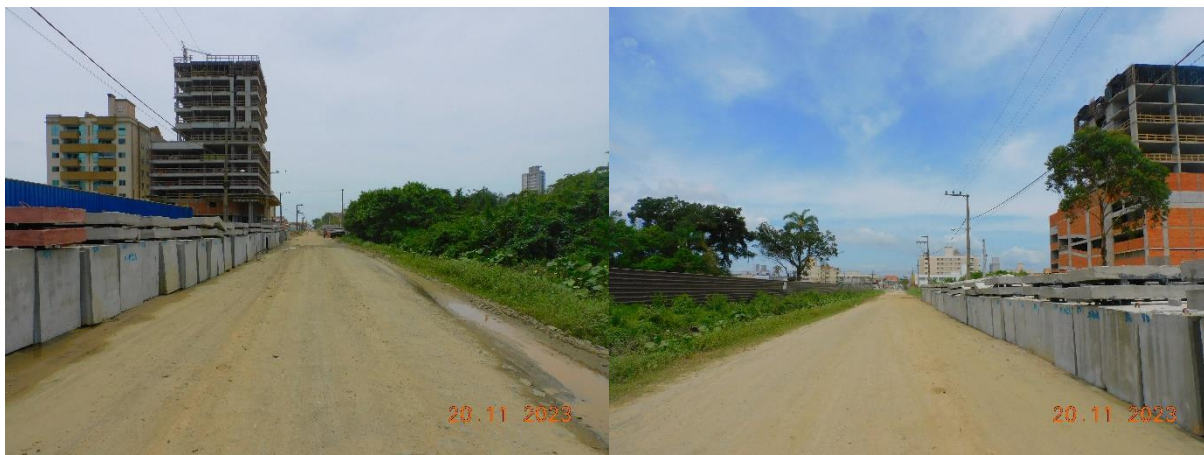
Figura 10- Registro da Avenida Santino Ludovino Voltolini, um dos acessos ao empreendimento. Fonte: RIBAS Consultoria Ambiental, 2023.
