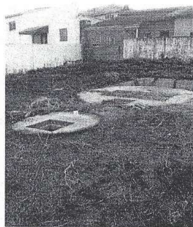
Figura 19 – Vista geral da EE-04.
