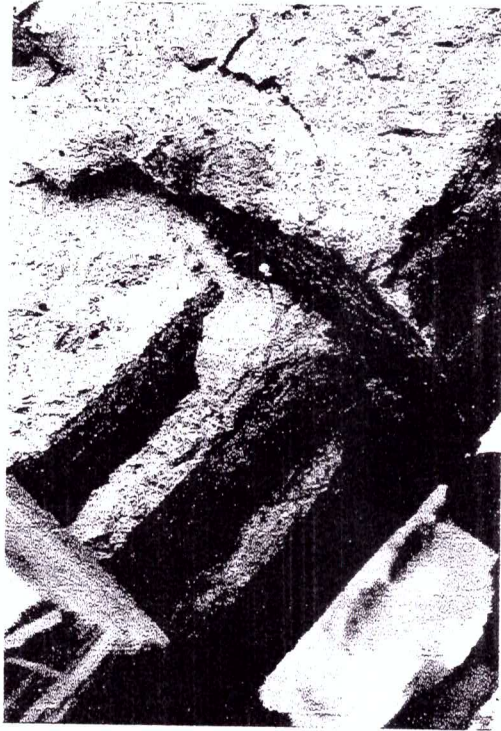
FOTO 2: Detalhe das armaduras corroídas, sem condições de cumprir sua função estrutural.
