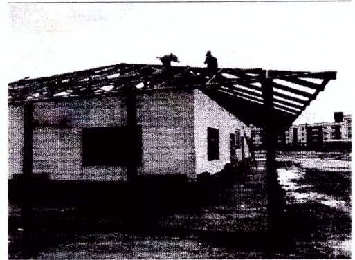
Estrutura de madeira da cobertura
