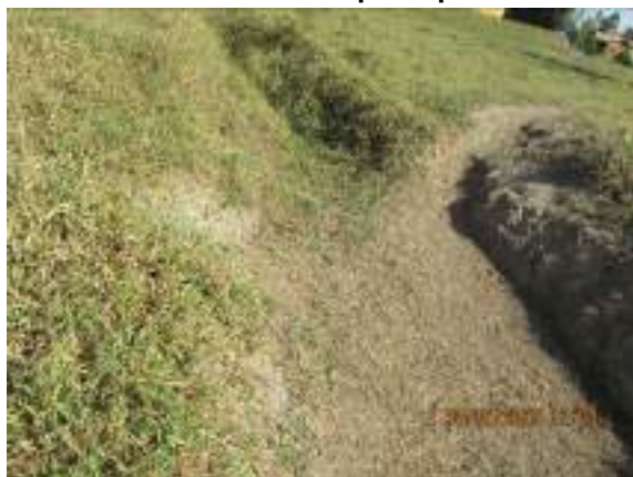
a. Canal de drenagem "A" que desagua na principal vala de drenagem da microbacia. Coordenada UTM: 740145.41 m E 6993280.06 m S
