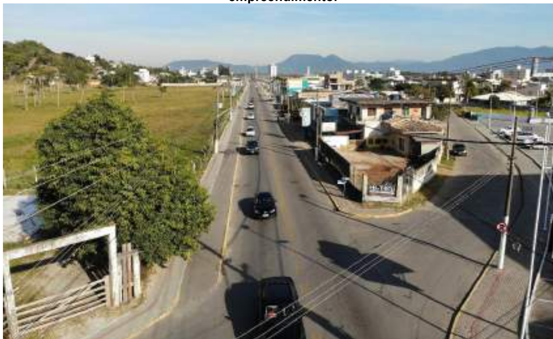
Figura 35. Vista parcial das edificações existentes na quadra limítrofe a área prevista para o empreendimento.
