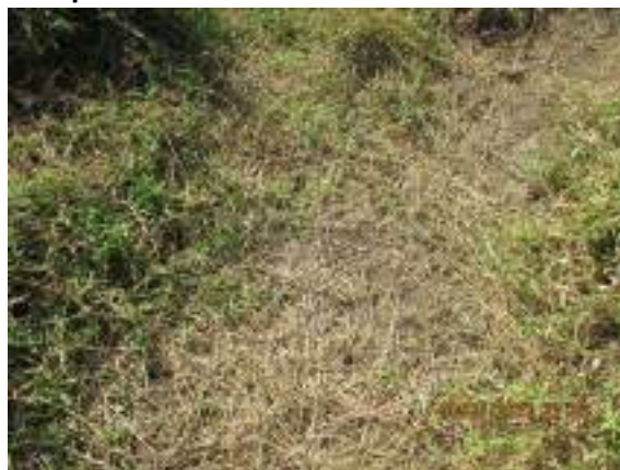
b. Canal de drenagem "B" que desagua na principal vala de drenagem da microbacia. Coordenada UTM: 740197.81 m E 6993277.16 m S
