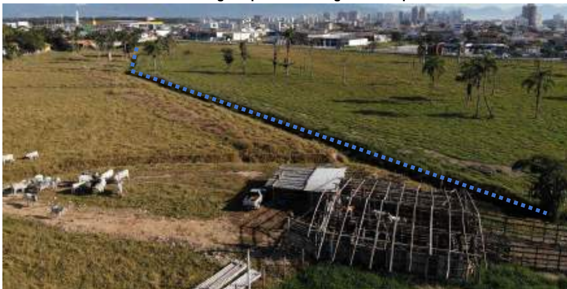
Figura 23. Vista parcial do corpo d'água principal da microbacia que recebe o direcionamento das águas pluviais da região do empreendimento.
