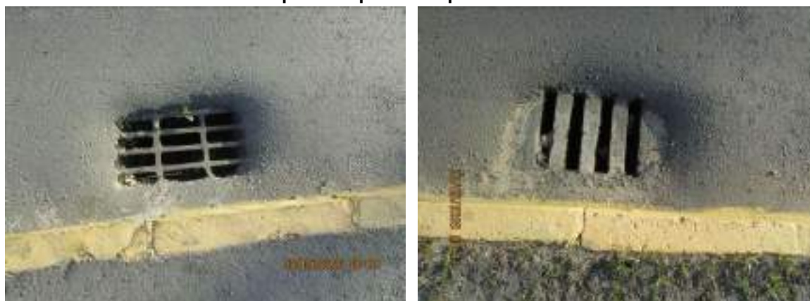
Figura 27. Vista da drenagem pluvial existente na Av. Governador Celso Ramos em frente a área prevista para o empreendimento.
