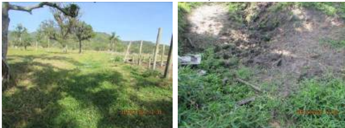
Figura 22. Registro fotográfico do trecho de drenagem adicional identificado no levantamento de campo.
