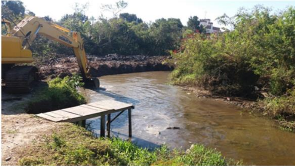
Foto 3 - Execução de Desassoreamento no Rio da Vó, Bairro Perequê (2017). Fonte: Defesa Civil, 2017.
