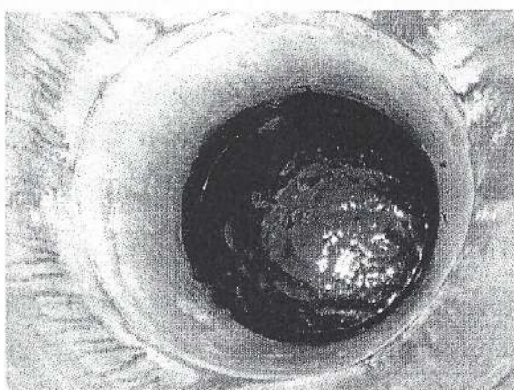
Figuras 1 e 2: Poços de visita cheios de efluente sanitário.
