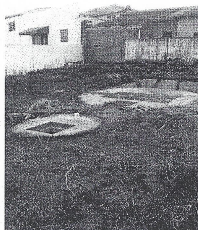
Figura 19 – Vista geral da EE-04.
