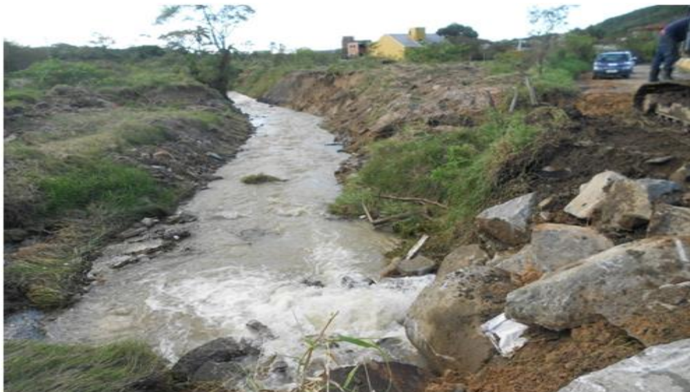
Foto 4: Execução de Desassoreamento no Rio Perequezinho, Bairro Vila Nova (2017). Fonte: Defesa Civil, 2017.
