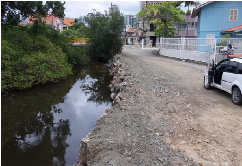
Foto 6: Contensão de Erosão, Rua Capitão Gualberto Leal Nunes, Bairro Centro
