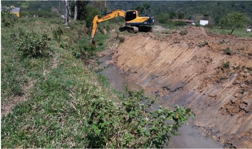
Foto 5: Desassoreamento do rio Perequezinho, Bairro Vila Nova (2018)
