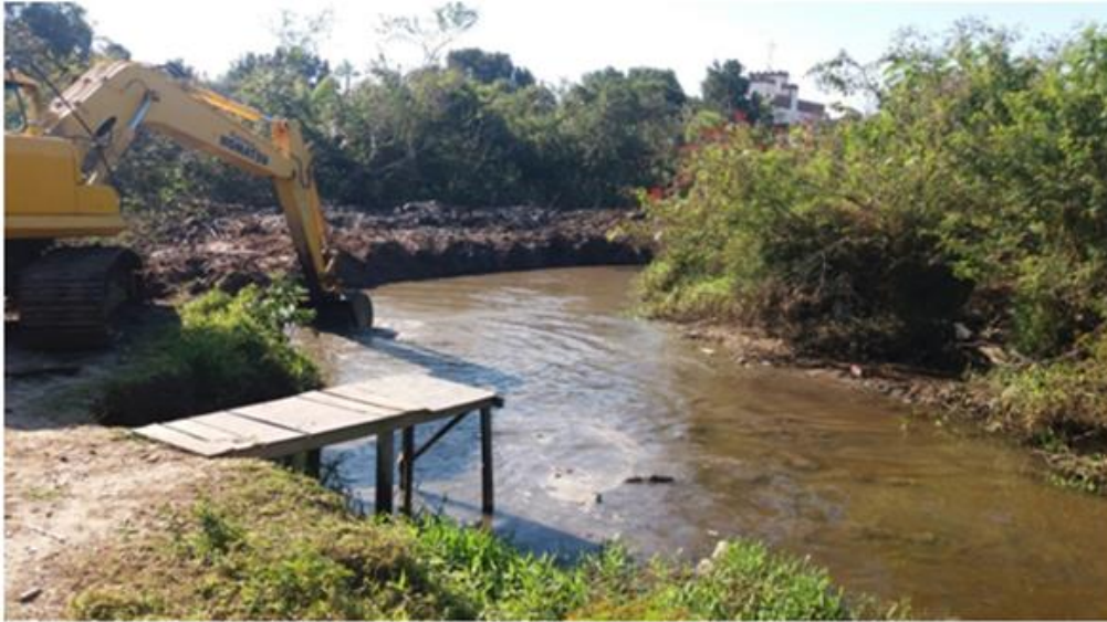
Foto 3: Execução de Desassoreamento no Rio da Vó, Bairro Perequê (2017). Fonte: Defesa Civil, 2017.
