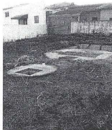
Figura 19 – Vista geral da EE-04.
