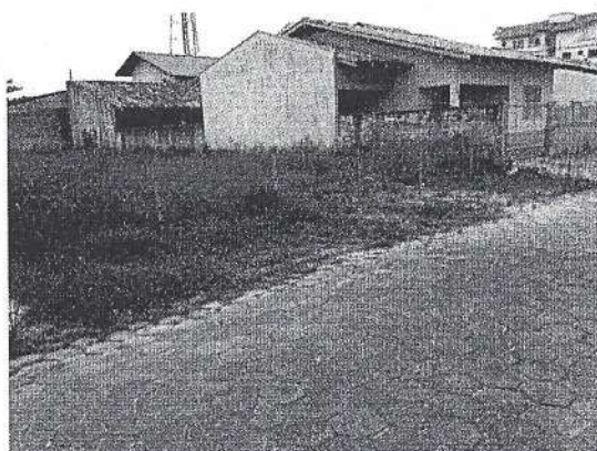
Figura 13- Terreno baldio sem CI de espera.
