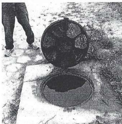
Figuras 1 e 2: Poços de visita cheios de efluente sanitário.
