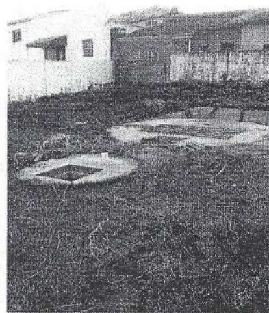
Figura 19 – Vista geral da EE-04.
