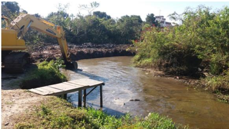
Foto 3 - Execução de Desassoreamento no Rio da Vó, Bairro Perequê (2017). Fonte: Defesa Civil, 2017.
