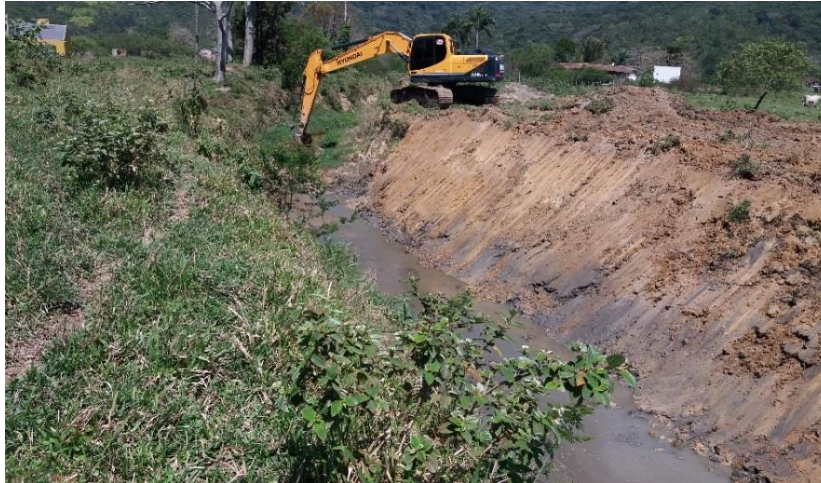
Foto 5 - Desassoreamento do rio Perequezinho, Bairro Vila Nova (2018)
