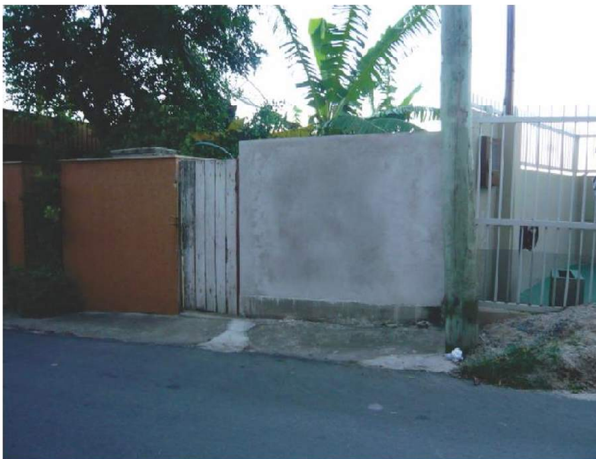
Acessos para a praia. Foto abaixo, servidão pública fechada com portão (Fotos: Raquel Mombelli e Erika Nakazono - janeiro a julho de 2015).
